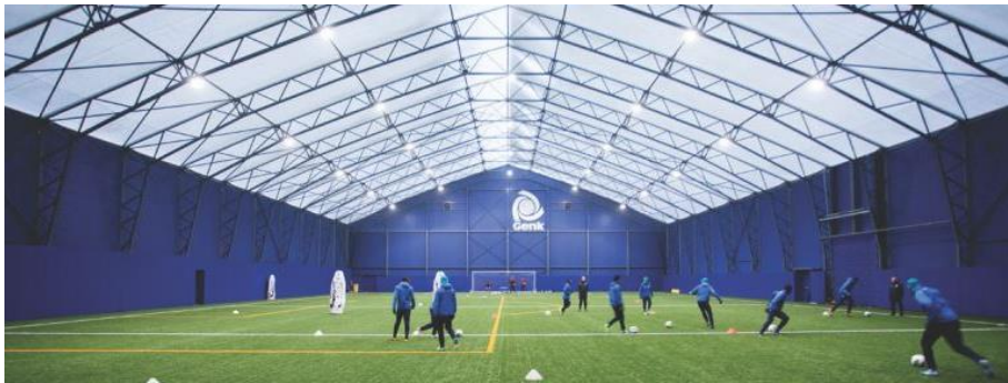
Abbildung 58: Beispiele für eine realisierte Spielfeldüberdachung in Genk, Belgien.
