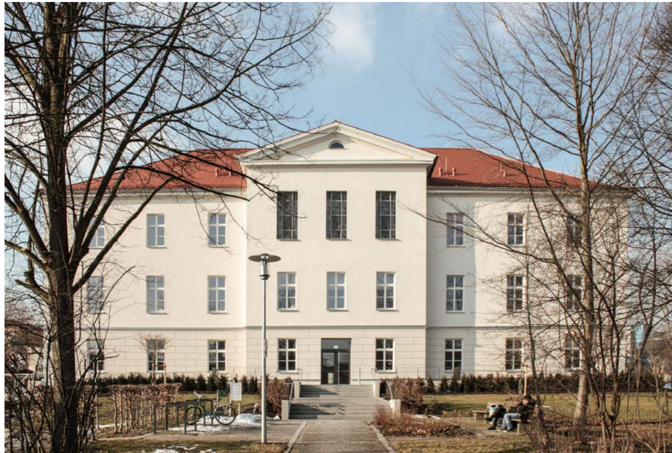
Südansicht des VHS-Gebäudes (Quelle: www.moa-arch.de)
