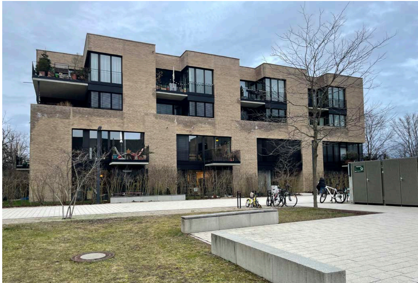
Fassadenansicht (Foto: Sophie Holzner)
