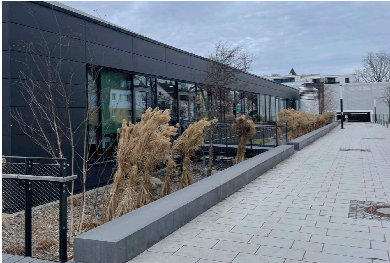
Eingangsbereich (Foto: Sophie Holzner)
