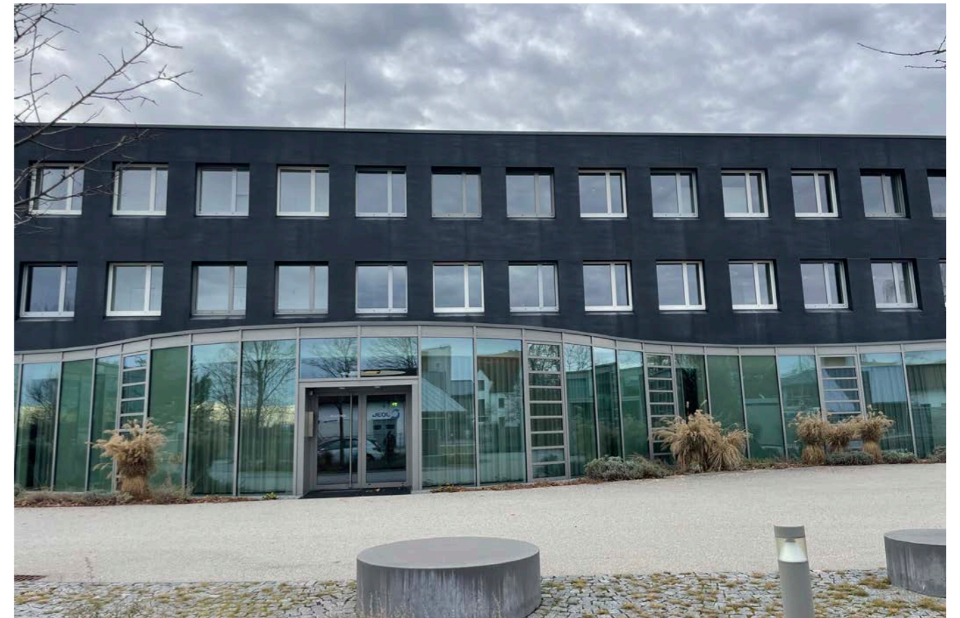
Eingangsbereich (Foto: Sophie Holzner)
