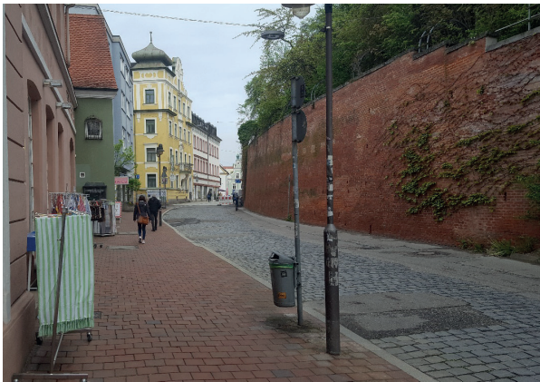
1 Nördliche Bahnhofstraße mit Dombergmauer
