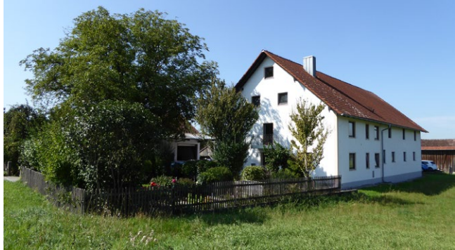
Abb. 87: Putzfassade und Satteldach
