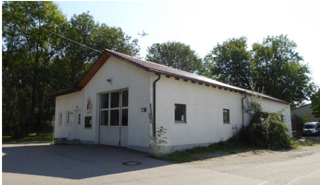
Abb. 53: Gebäude der Freiwilligen Feuerwehr
