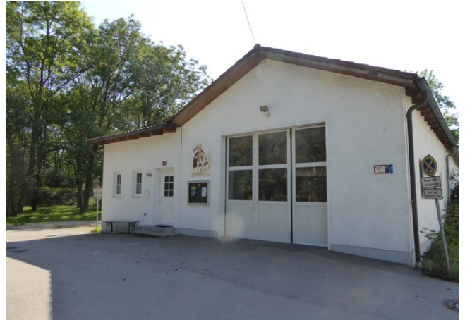
Abb. 40: Gebäude der Freiwilligen Feuerwehr
