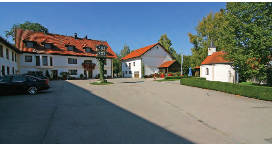
Abb. 106: Durchfahrt durch den großen Hof im Zentrum
