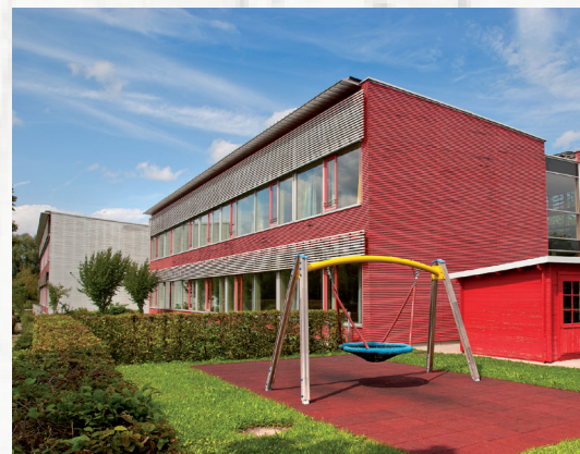
Förderzentrum in Pulling
