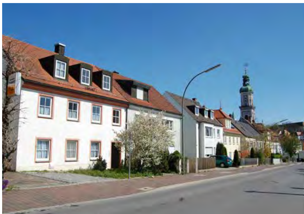
Abb. 29: Außerhalb des Ziegeltores kam es an der Prinz-Ludwig-Straße bereits Anfang des 19. Jh. zur planmäßigen Errichtung von Reihenhäusern mit typischen Vorgärten mit Einfriedungen.
