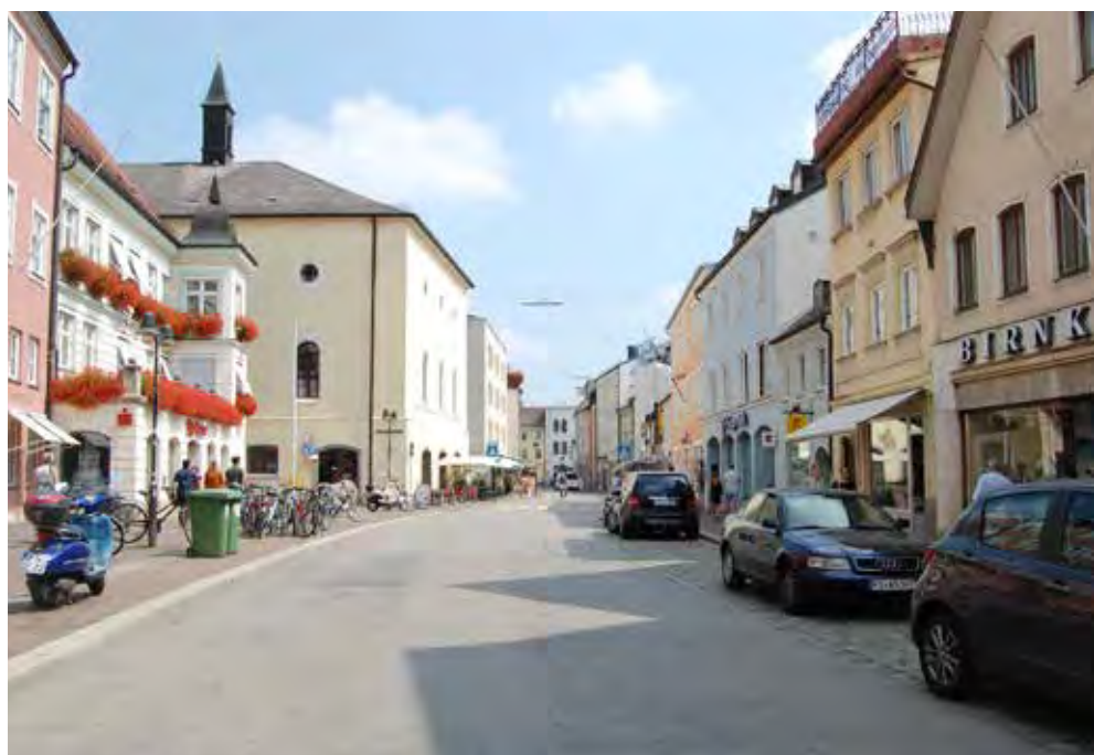
Abb. 23: Blick von Westen in die Untere Hauptstraße mit der markanten, in den Straßenraum ragenden ehem. katholischen Mädchenschule St. Korbinian.
