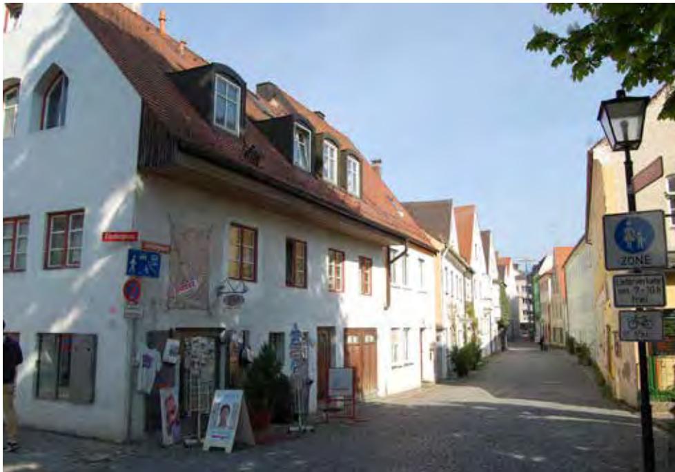
Abb. 24: Blick von Süden, Höhe Fischergasse, in die Luckengasse mit ihrer insgesamt noch gut überlieferten historischen Bausubstanz des 15.-19. Jh.
