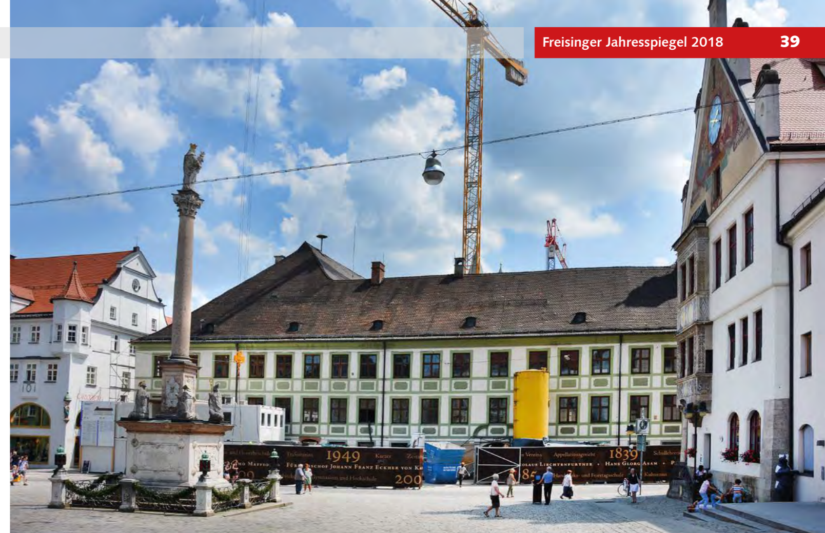
Freising baut, Freising investiert: Die markantesten Bau- und Sanierungsarbeiten sind derzeit in der Innenstadt zu sehen. Das Asamgebäude ist ein gutes Beispiel für eine sinnvolle Investition in die Zukunft. Hier wird in etwa dreieinhalb Jahren für alle Bürgerinnen und Bürger ein Kulturzentrum fertiggestellt, auf das man stolz sein wird. Links im Bild ist das vor einigen Jahren grundsanierete Markushaus, in dem Stadtkämmerei und Stadtkasse ihren Sitz haben.
