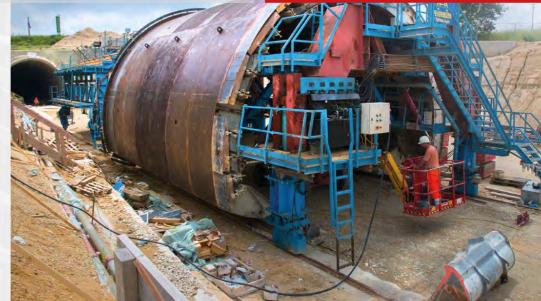
Arbeiten für die Röhre: Im bergmännischen Teil steht neuerdings der Innenausbau im Mittelpunkt, während im südlichen Abschnitt noch die Docks entstehen. Zur Herstellung der Bohrpfehlwände sind riesige Geräte im Einsatz. Derweil laufen ganz im Süden die Anschlussarbeiten der Tangente an die Kreuzung von Staats- und Kreisstraße (Bilder von oben nach unten). Fotos: Stadt Freising (5), MASELL (2), edr (1)
