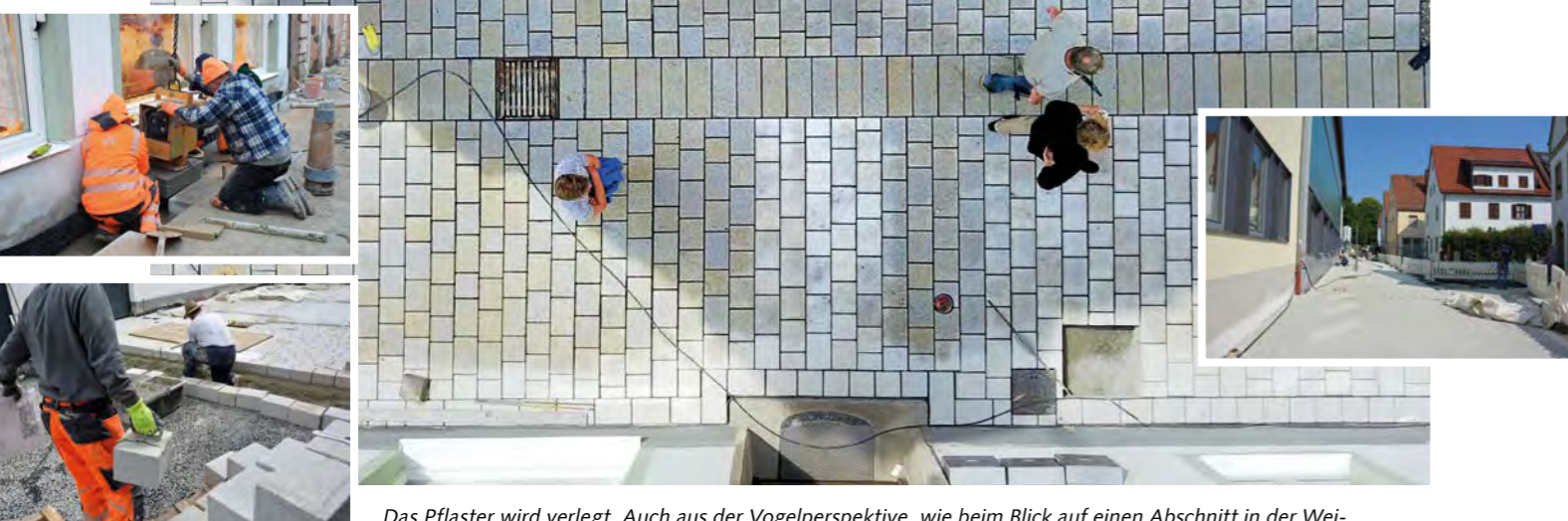
Das Pflaster wird verlegt. Auch aus der Vogelperspektive, wie beim Blick auf einen Abschnitt in der Weizengasse, macht der niveaugleiche Ausbau richtig was her. Fotos: Stadt Freising (5), Wadle Bauunternehmung GmbH (1)
