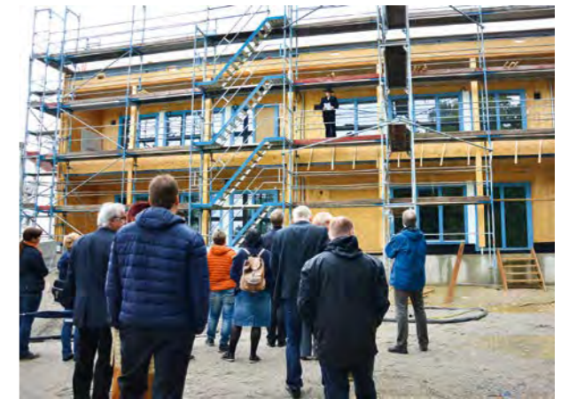
Viel Platz zum Spielen und Lernen wird der Neubau der KiTa Wetterstein bieten. Beim Richtfest gab es viele gute Wünsche für die künftigen Nutzer. Foto: Stadt Freising
