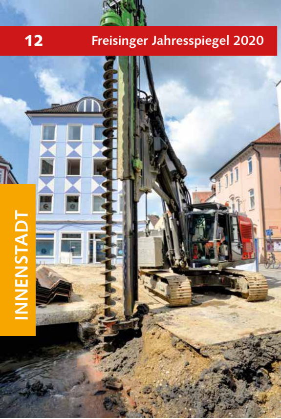
Hätten Sie es gewusst? Nahezu alle Gebäude in der Altstadt haben keinen Keller. Wie in Venedig werden sie nur von Eichenpfählen gestützt. Das Bachbett der Moosach gründet ebenso auf Holzpfählen. Damit sowohl Häuser als auch das neue Bachbett gesichert sind, werden mit aufwendiger Bohrtechnik massive Betonpfähle eingesetzt (Bilder links). Parallel dazu wird bereits gepflastert (unten). Das Bild oben zeigt das Rohrlager für das Wärmenetz vor dem mittlerweile abgebauten Kriegerdenkmal. Fotos: Stadt Freising (7)
