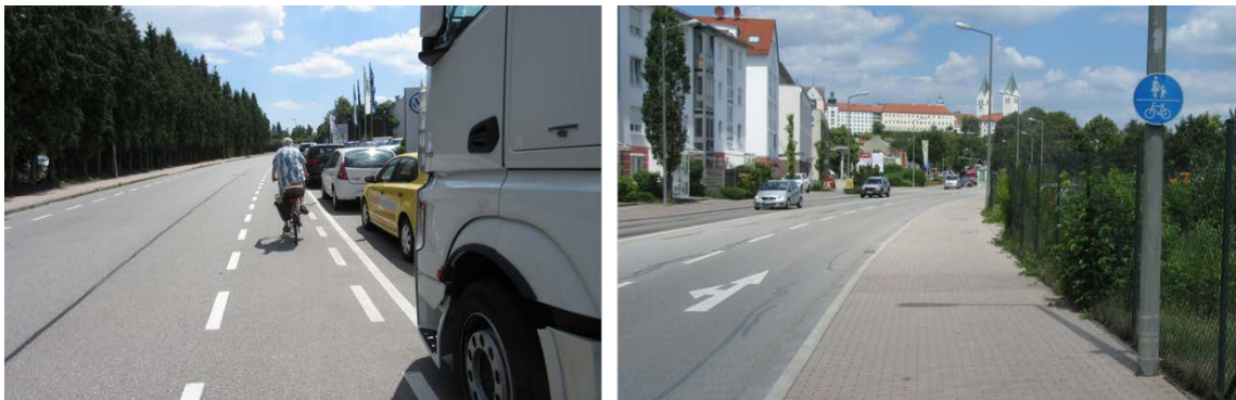
Fotos: Radverkehrsführung Schutzstreifen Haggertystraße, gemeinsamer Fuß-/ Radweg Ottostraße
