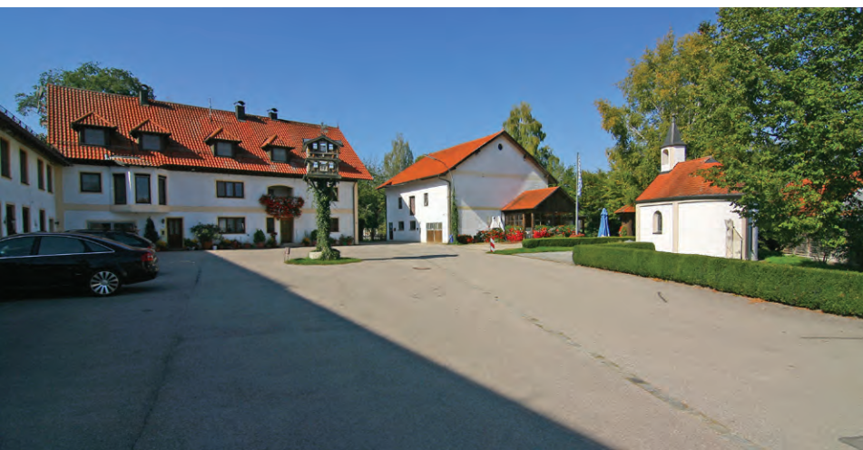
Abb. 85: Durchfahrt durch den großen Hof im Zentrum
