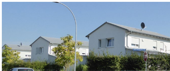
Abb. 53: Wohnnutzung im Bestand
