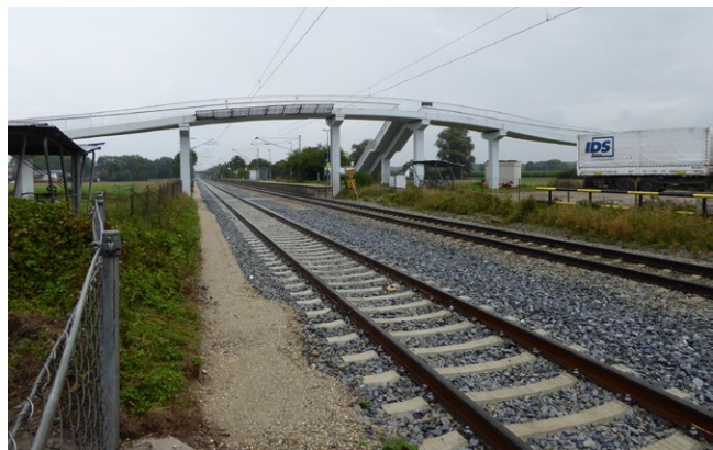
Abb. 45: Bahnstrecke mit Bahnübergang
