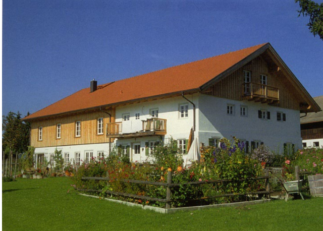
Abb. 22: Umnutzung Hofstelle zu Wohnen
