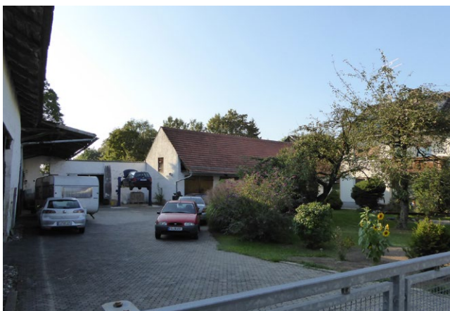
Abb. 97: Stellung der Gebäude als Gruppe
