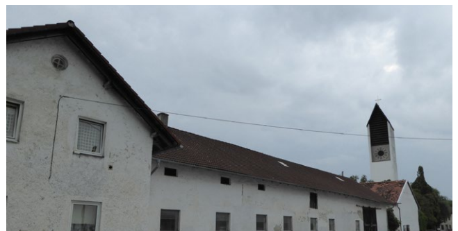
Abb. 37: Gebäudeensemble im Ortskern
