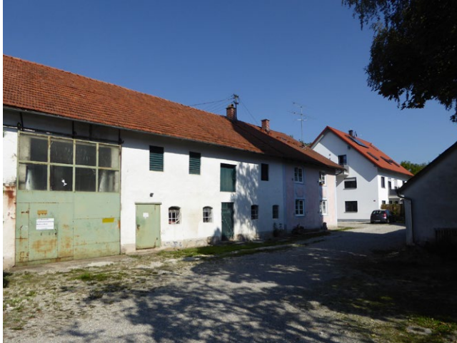
Abb. 93: Große Kubaturen der Gebäude
