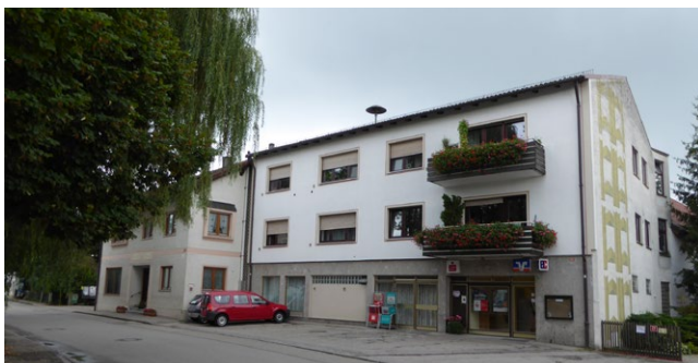
Abb. 36: Wohn/Geschäftsgebäude im Ortskern
