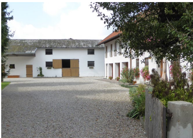
Abb. 86: Verputzte Fassaden, Holzelemente
