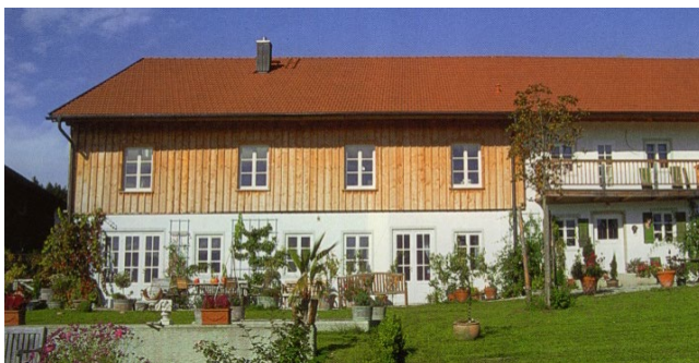
Abb. 24: Ausbau des Scheunenteils
