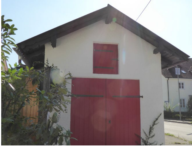
Abb. 82: Einfach gestaltete Fassade mit Holztür
