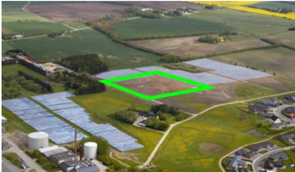
Abbildung 31: 19.000 m 3 Erdsonden-Speicher für rund 600 MWh/a in Brædstrup (DK)
