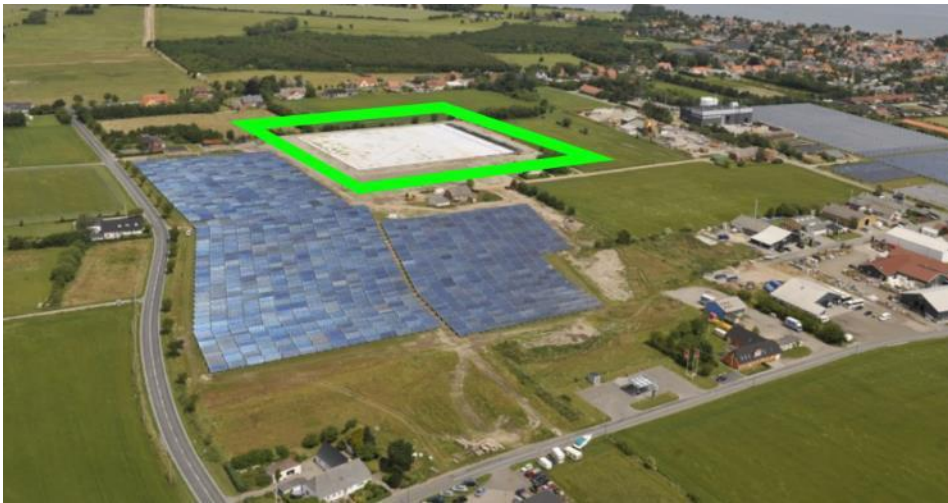
Abbildung 30: 75.000 \text{ m}^3 Erdspeicherbecken für rund 5.000 \text{ MWh/a} in Marstal (DK)
